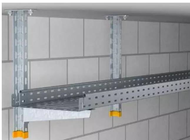
Figure 7 : fixation du chemin de câbles avec pendent
